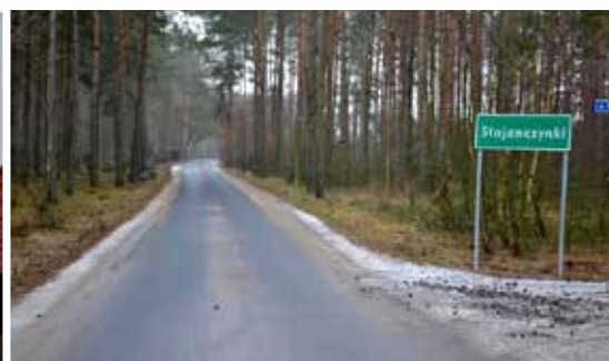
Wyremontowana droga w Zawalach
