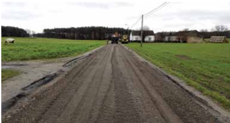
Zmodernizowano drogę gminną w Obrowie na ul. Leszczynowej
