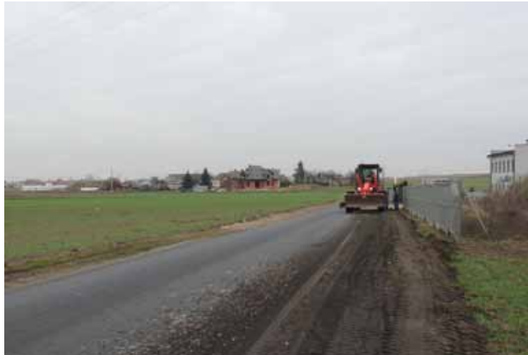
Wyrównywanie poboczy drogi Łążyn -Łążynek
