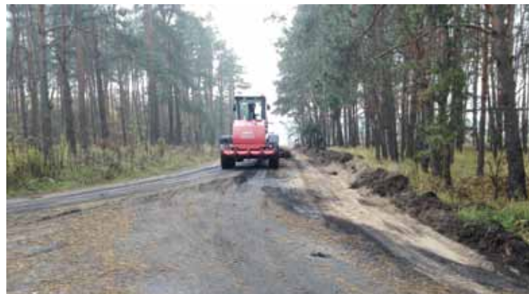
Porzerzenie drogi gminnej w Silnie ul. Spacerowa
