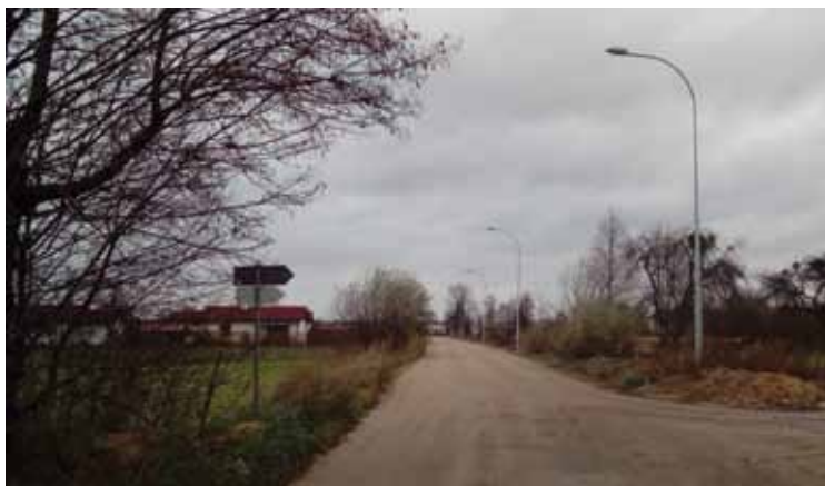
Wykonano podbudowę drogi gminnej w Osieku nad Wisłą na ul. Wiślanej
