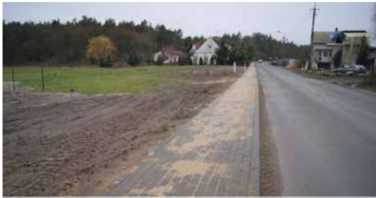
Oddano do użytkowania 200 mb chodnika przy drodze wojewódzkiej w Osieku nad Wisłą. Kostkę brukową dostarczył Zarząd Dróg Wojewódzkich, a Gmina Obrowo sfinansowała wybudowanie chodnika.
