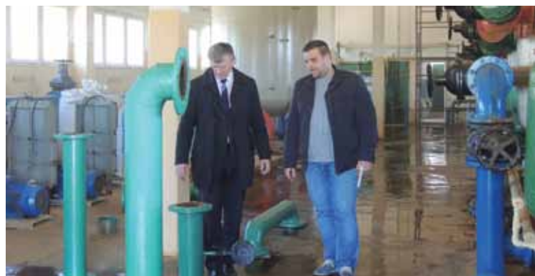
Wójt Andrzej Wiczyński i Kierownik Referatu Wodno - Ściekowego UG Obrowo Artur Słomkowski podczas nadzoru prac remontowych na Stacji Uzdatniania wody w Dobrzejewicach.
