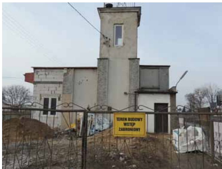
Trwają prace remontowe budynku OSP w Kawęczynie
