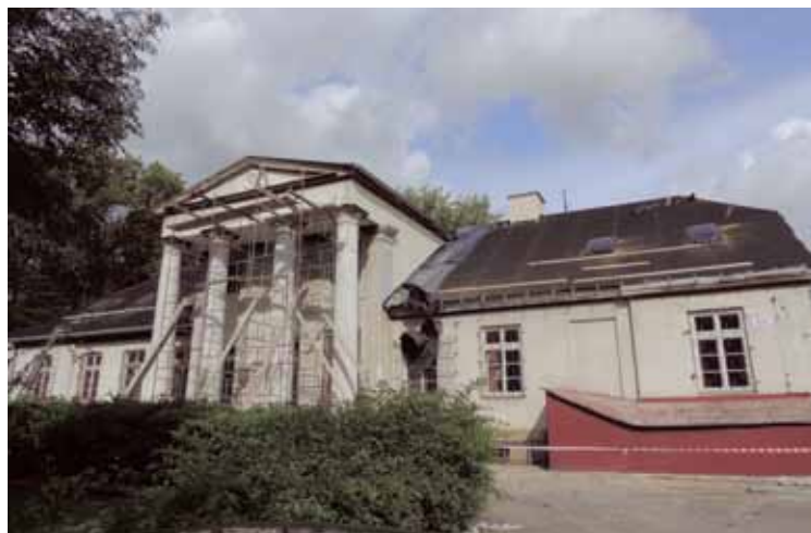
Remont dachu na dworku szlacheckim w Obrowie.
