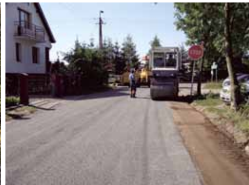
Droga Osiek n. Wisłą w kierunku cmentarza.
