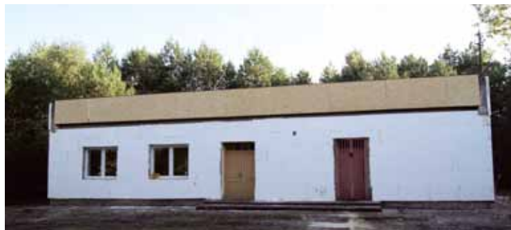
Remont i docieplenie świetlicy wiejskiej w Stajenczynekach.
