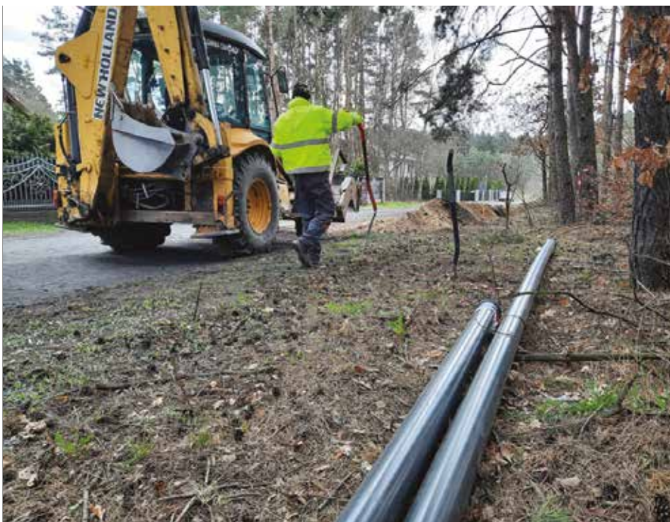
Budowa wodociągu w Kawęczynie.
