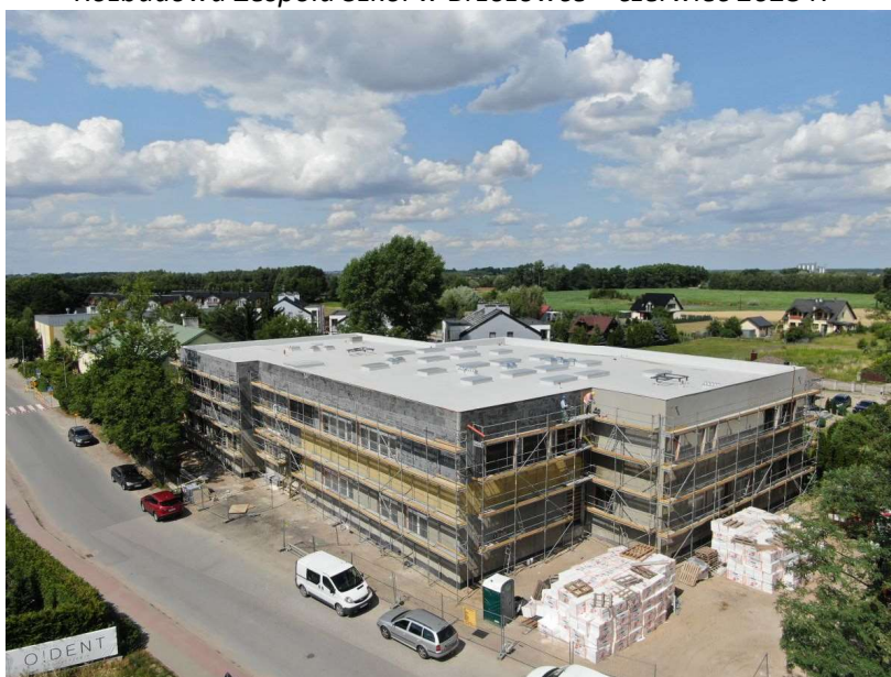
Rozbudowa Zespołu Szkół w Brzozówce – czerwiec 2023 r.
