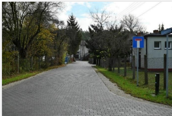
Osiek nad Wisłą ul. Jarzębinowa
